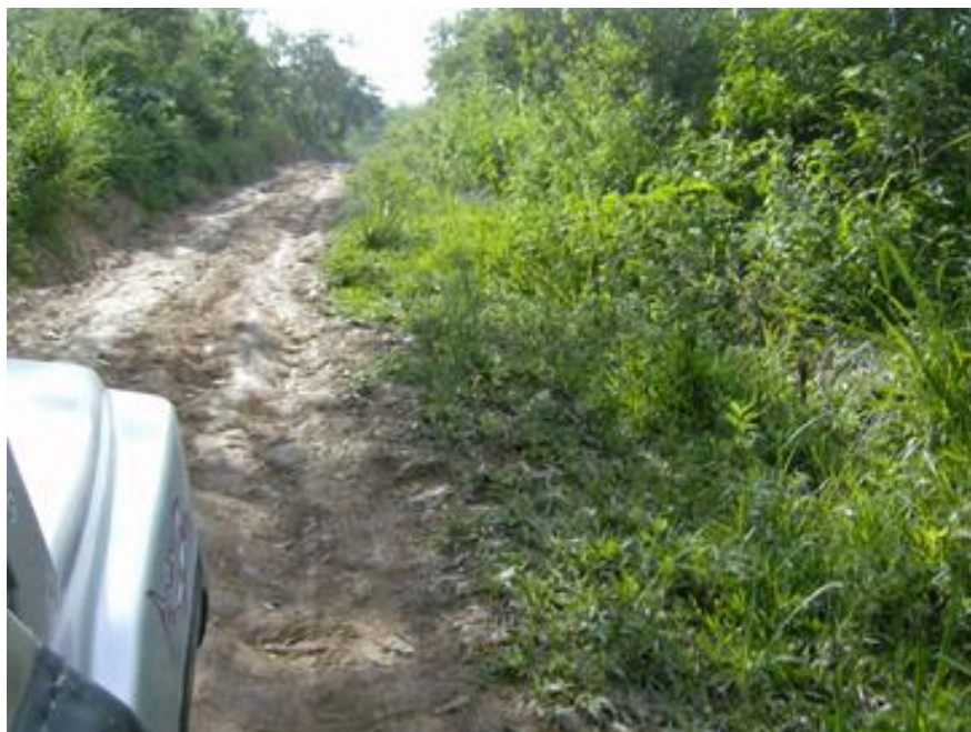
Figura 37- Estrada do Araçazeiro (A)
