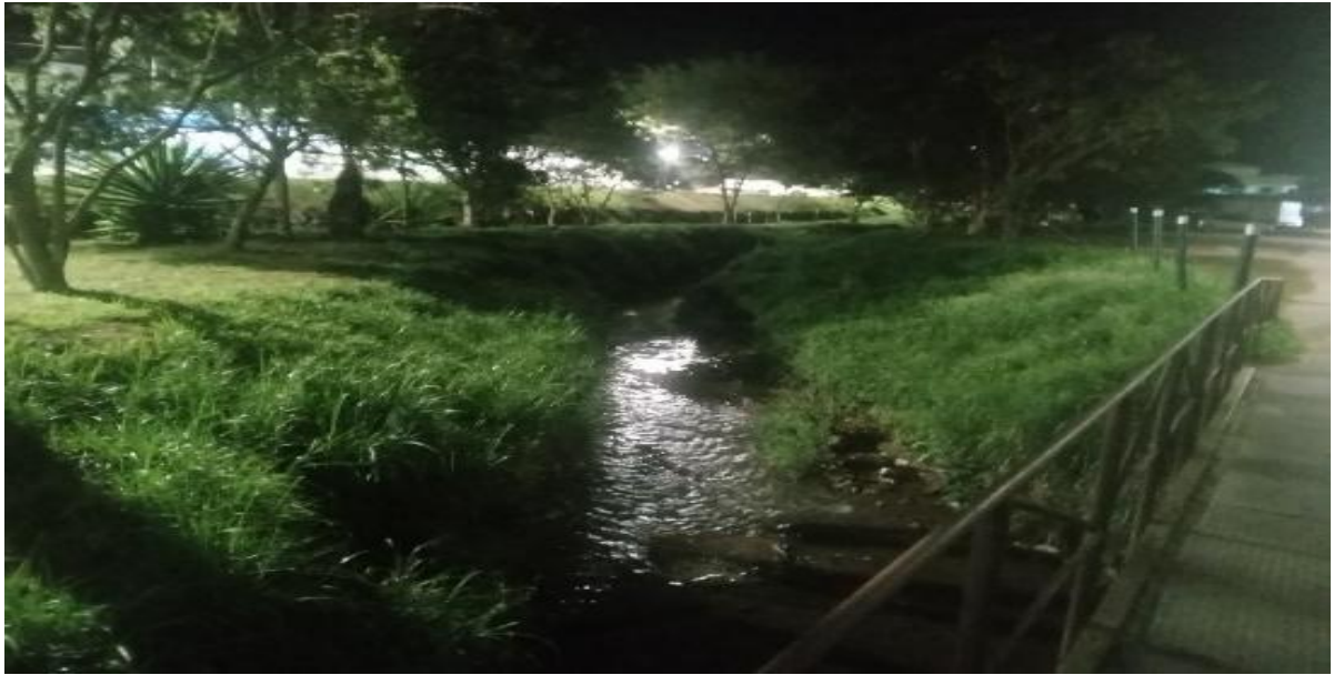
Figura 4 – O Rio Meudon, afluente do Paquequer, encontra-se muito degradado e assoreado
