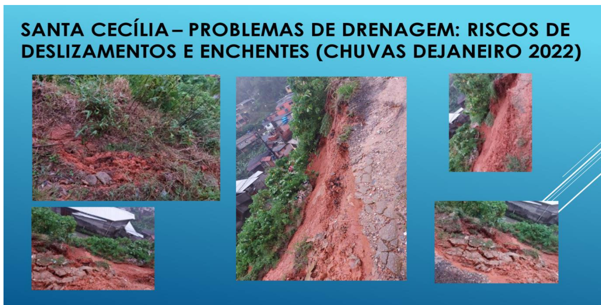
Figura 14 – Eventos provocados pelas chuvas em janeiro de 2022
