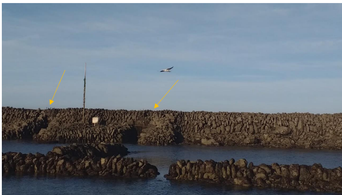
Figura 4 - Écluses à poissons na Île d' Oléron com as grades entre os muros de pedra.
