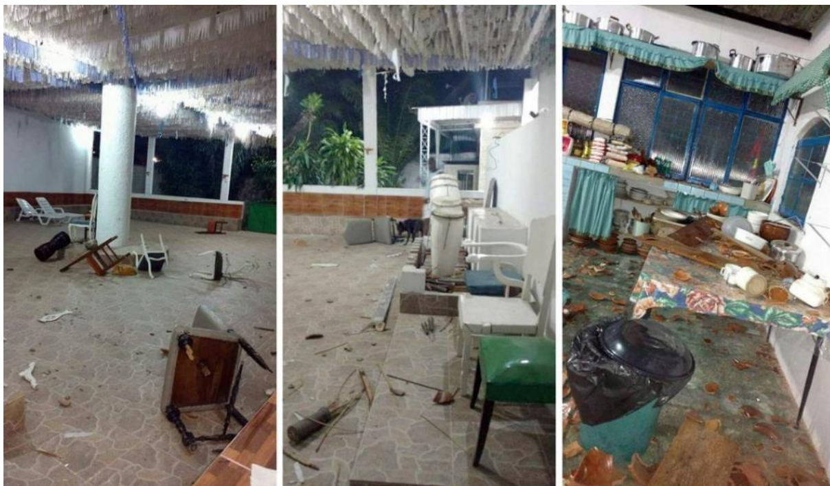
Figura 28 – Salão central, atabaques e cozinha do terreiro destruídos por traficantes.
