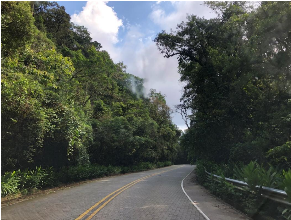
Figura 8 - Trecho de curva da rodovia RJ-165.
