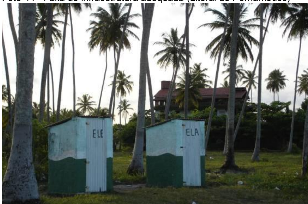
Foto 44 - Falta de infraestrutura adequada (Litoral de Pernambuco)
