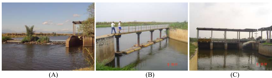
Figura 52 – Subsistema de captação do sistema Imunana-Laranjal
