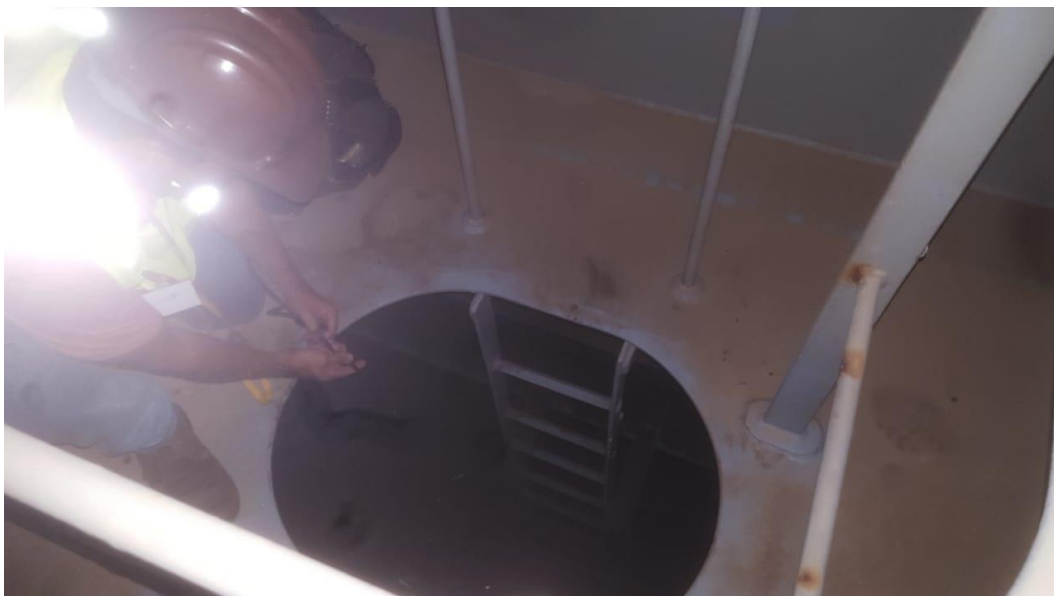
Figura 24 - Vista interna de um tanque de lastro com abertura para outro nível do tanque do Navio teste
