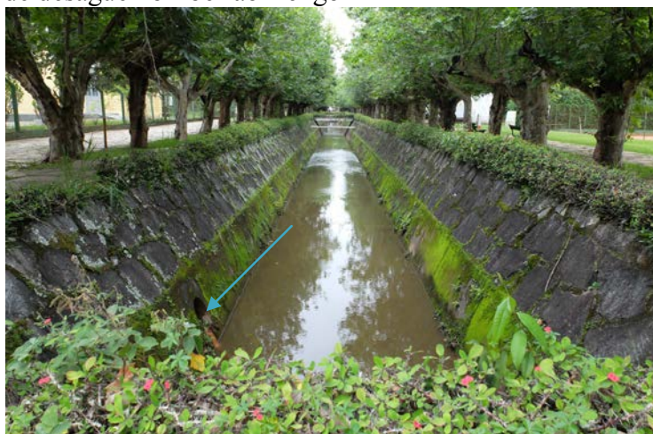
Figura 19 – Local de desague no ribeirão Bengo
