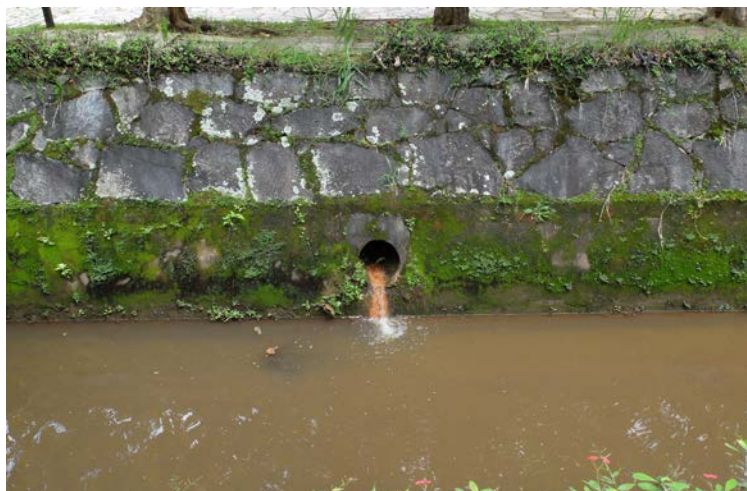
Figura 18 – Desague no ribeirão Bengo
