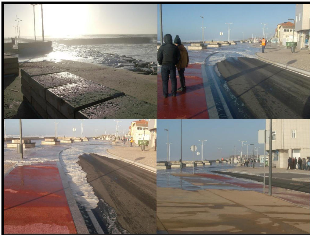
Figura 38 – Galgamentos do mar na “Avenida Marginal” no Furadouro.
