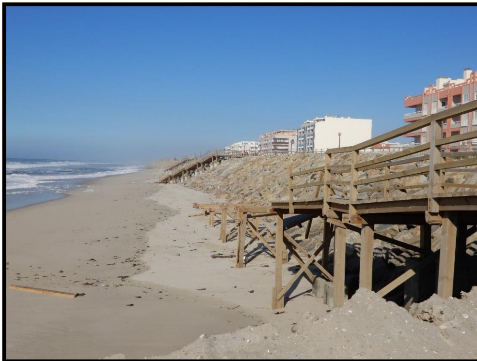
Figura 41 – Erosão costeira na Vagueira.
