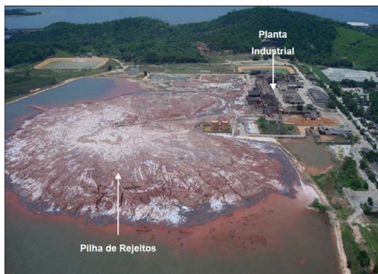
Figura 20 - Foto aérea da pilha de rejeito da Cia Ingá e a Planta Fabril
