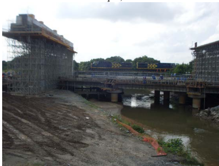
Figura 14 – Obras sobre o rio Mazomba/Cação, 2012
