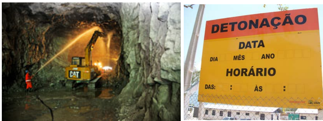
Figura 31 – Fotos: Abertura do túnel de acesso ao Porto Sudeste e Placa das detonações
