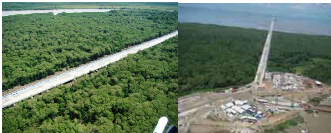
Figura 02 – Obras da TKCSA em área de mangue na Baía de Sepetiba/RJ
