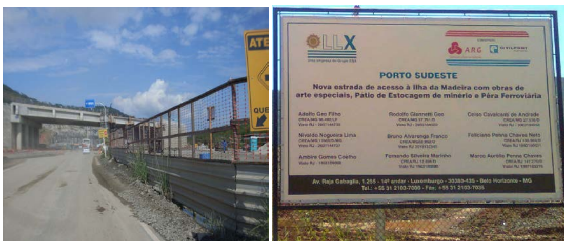
Figura 35 – Fotos: Obras na estrada de acesso a Ilha da Madeira e a Placa da LLX.
