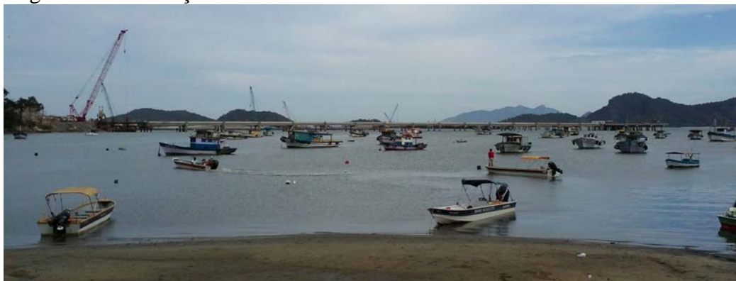
Figura 44 - Construção do Pier - PortoSudeste da LLX/MMX.
