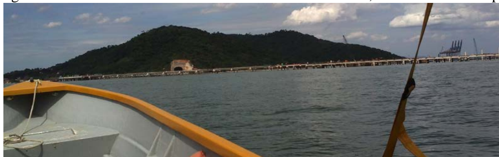
Figura 45 - Pier da LLX e saída do túnel de acesso ao Porto, vista da baía de Sepetiba
