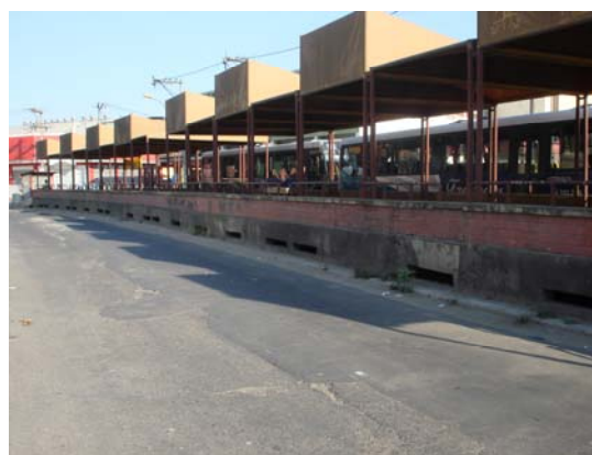
Figura 30 – Rua Almirante Nestor Pinto. Passarela de ônibus com boca de lobo construída em cima do Rio Alcântara (Ponto 12.1)
