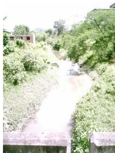
Figura 13 - Rua Paulo Leroux.
