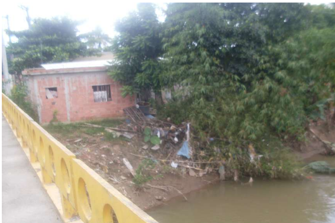
Figura 85 – Domicílio em situação irregular, na sub-bacia do rio Saracuruna, RJ
