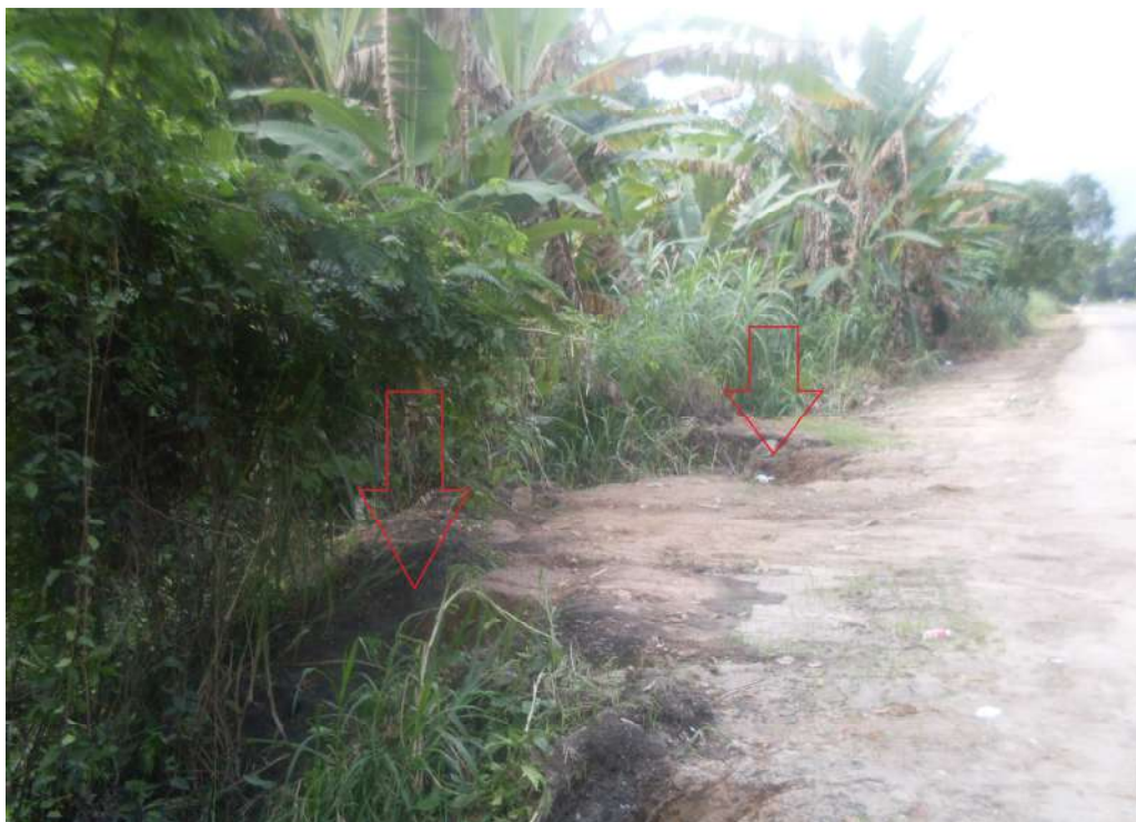
Figura 96 – Cicatrizes de erosão às margens do rio Saracuruna, RJ
