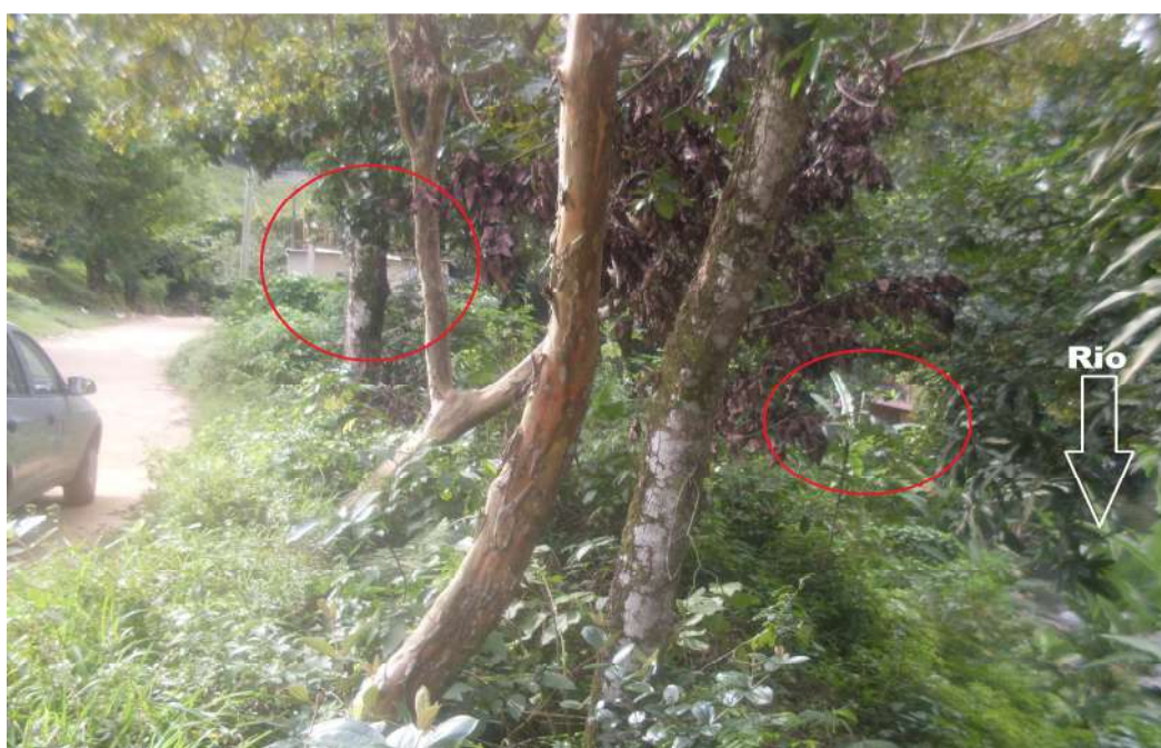
Figura 101 – Nível baixo de impermeabilização na faixa marginal do rio Saracuruna (médio curso, em Xerém), sub-bacia do rio Saracuruna, RJ
