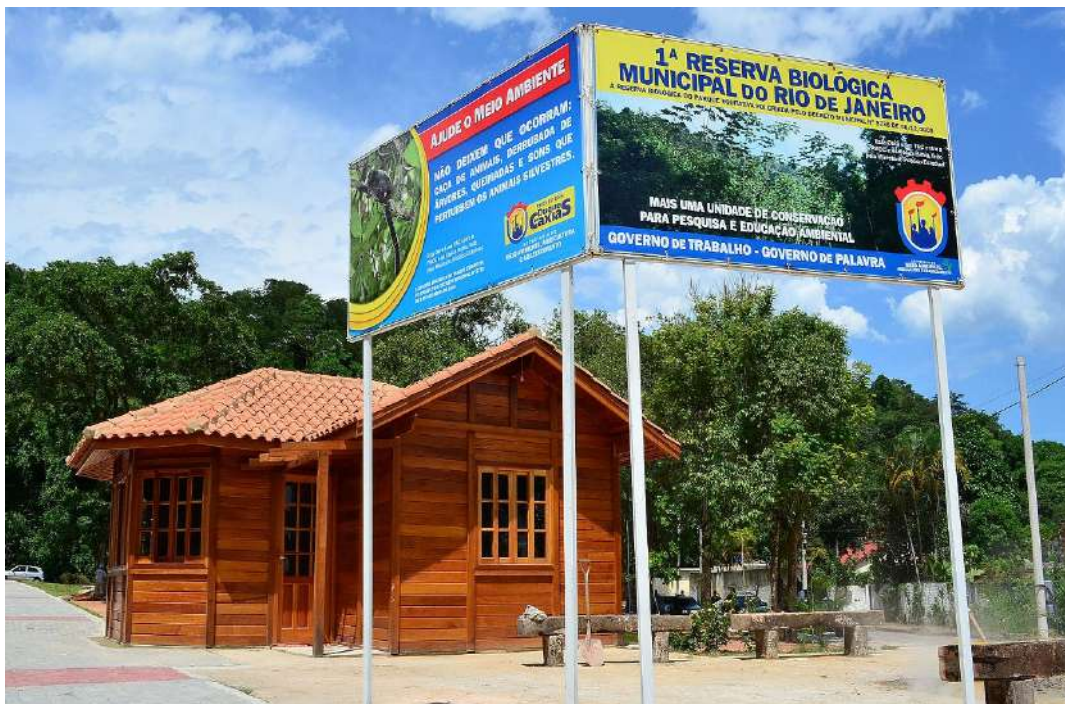
Figura 75 – Sede da Rebio do Parque Equitativa, sub-bacia do rio Saracuruna, RJ
