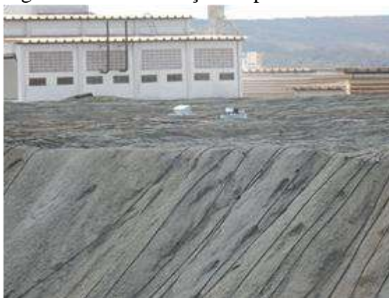
Figura 28 - Monitoração na pilha de lixiviação
