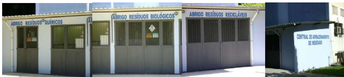
Figura 25: Foto da Central de Armazenamento de Resíduos da UERJ.
