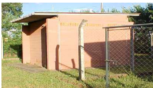
Figura 12: Abrigo de resíduos químicos.
