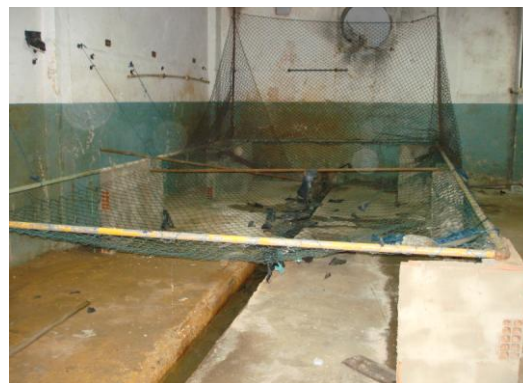
Figura 10 - Local para lavagem do PET - COOPAMA
