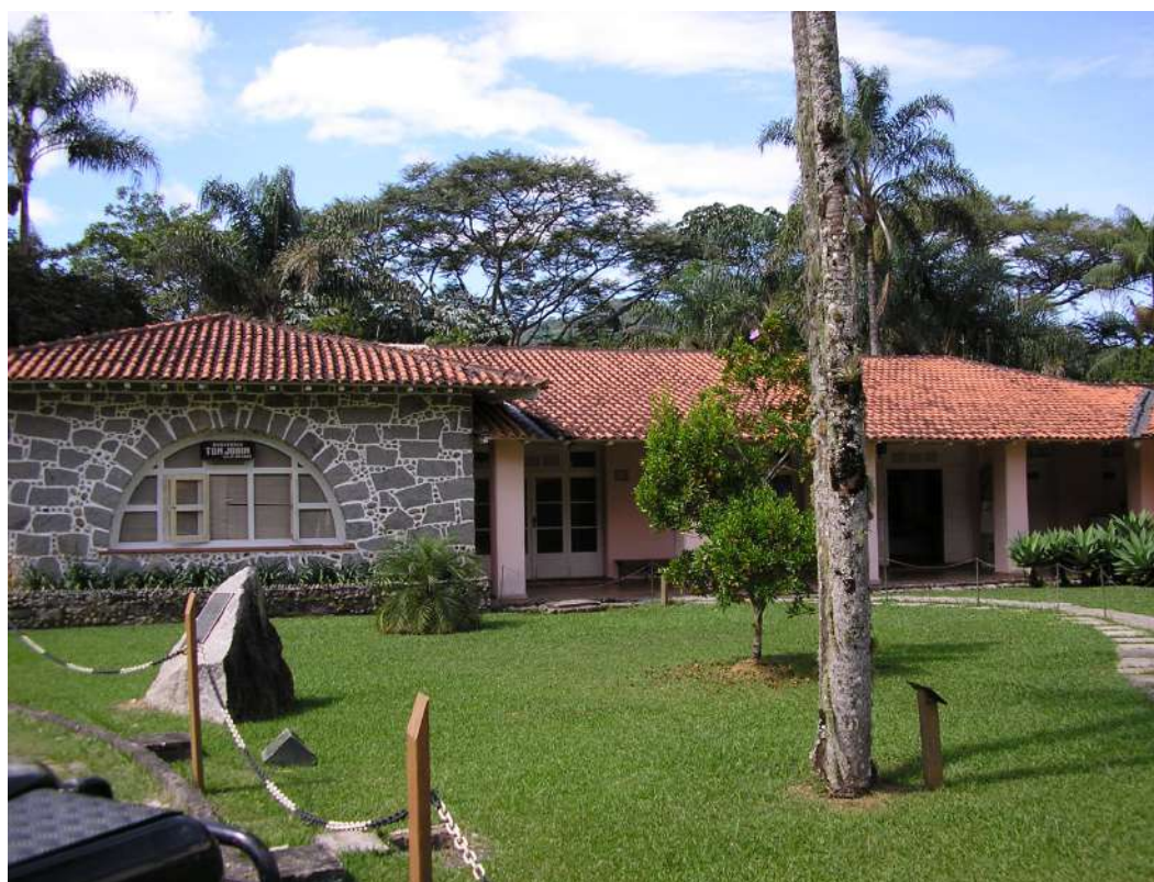
Figura 74 – Vista lateral do Centro de Visitantes.
