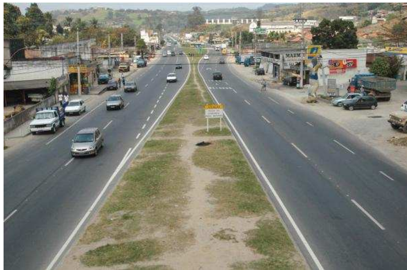
RJ 106 – trecho São Gonçalo
