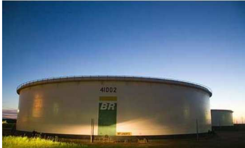
Figura 20 – Tanque de armazenamento de petróleo Fonte: EIA COMPERJ, 2007.
