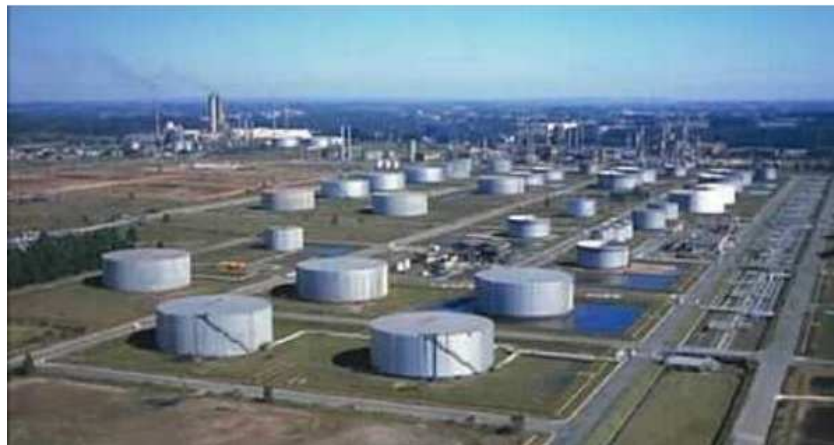
Figura 21 – Estocagem de produtos acabados Fonte: EIA COMPERJ, 2007.
