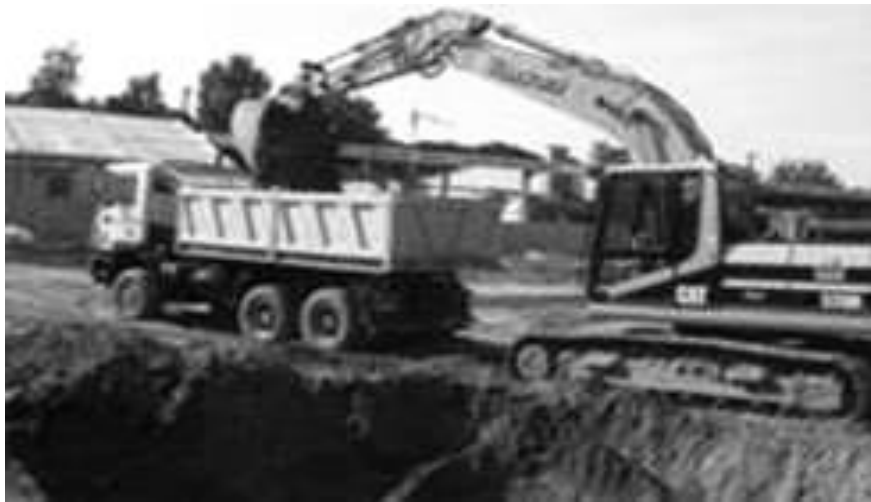
Figura 26 - Aeração - Biopilha dinâmica.
