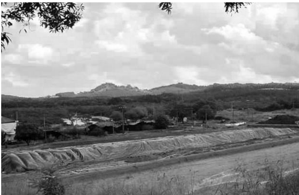
Figura 28 - Sistema de Cobertura
