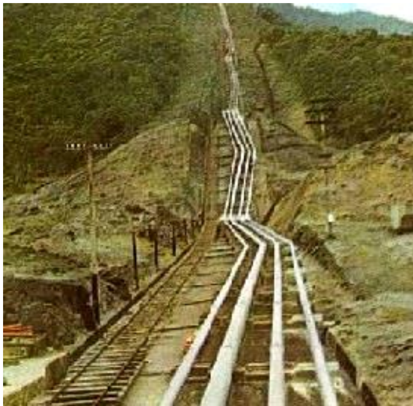
Figura 7 - Oleoduto em construção
