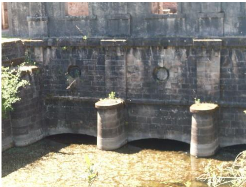
Figura 13- Barramento do Arroio "Cuñapirú"
