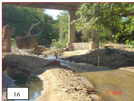
Figura 16- Localidade: Jaú do Tocantins, ponto de coleta EN143-11 (26/10/2005). Fonte: LSO.
