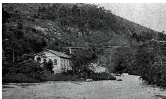
Usina Hidrelétrica Marmelos Zero (1888) - 4 MW - Juiz de Fora (MG)
