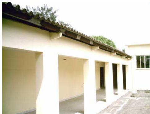
Figura 6 – Amplo telhado para captação da água pluvial
