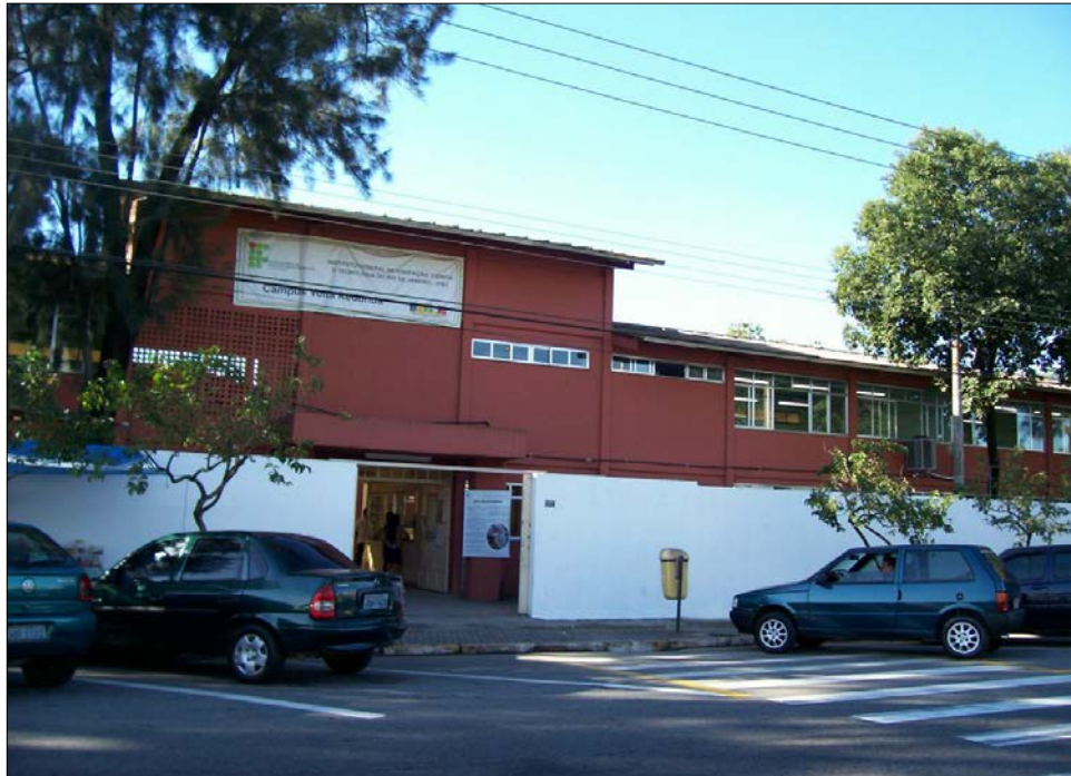
Figura 2 – Fachada do prédio onde está instalado o Campus Volta Redonda.
