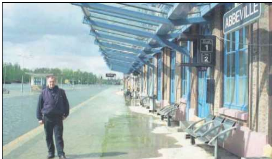
Figura 97 – Estação ferroviária de Abbeville durante a inundação de 2001.
