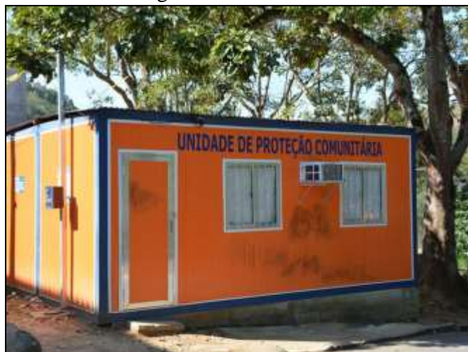
Figura 86 – Container sede de uma UPC em Nova Friburgo.
