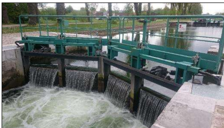
Figura 100 – Obras hidráulicas em um rio de Abbeville.
