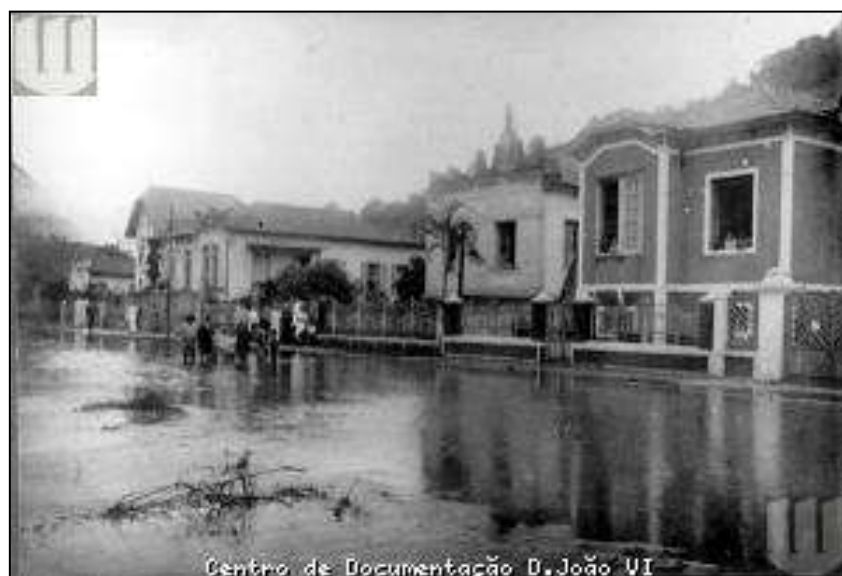
Figura 50 – Inundação na Av. Galdino do Vale, 1920.
